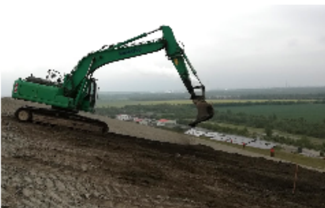
Einbau Rekultivierungsmaterial auf dem Deponiekörper
